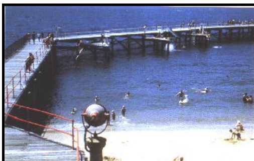
Photo 4 : Enclos métallique surmonté d'une passerelle en Australie.
